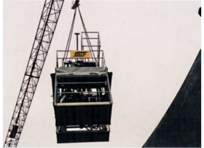
Ein doppelseitiges Circotech-System wird an den Arbeitsort gehoben.
